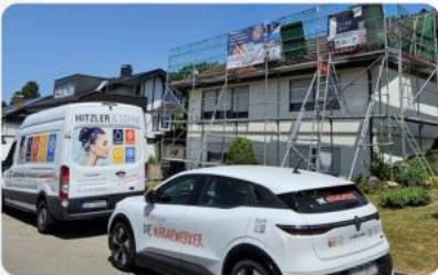
Umbau im bewohnten Haus
