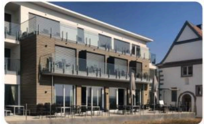
Altbau saniert, Neubau ergänzt
