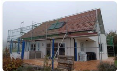
Vor der PV-Montage
