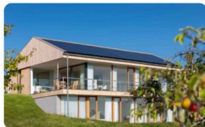
Photovoltaik für den Eigenstrom
